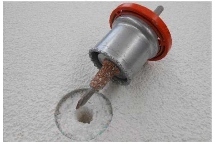
Mit dem Ejothem STR-Sanierfräser kann die Putzschicht abgefräst werden.
