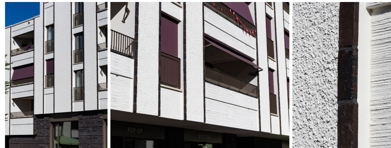
Die abwechselnden Oberflächenstrukturen, versetzten Fassadenelemente und horizontalen Bänder aus Klinkersteinen erfordern Präzision und Fachwissen in der Ausführung.
