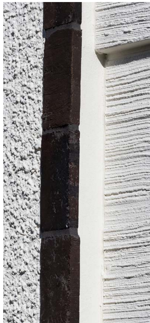
Die abwechselnden Oberflächenstrukturen, versetzten Fassadenelemente und horizontalen Bänder aus Klinkersteinen erfordern Präzision und Fachwissen in der Ausführung.
