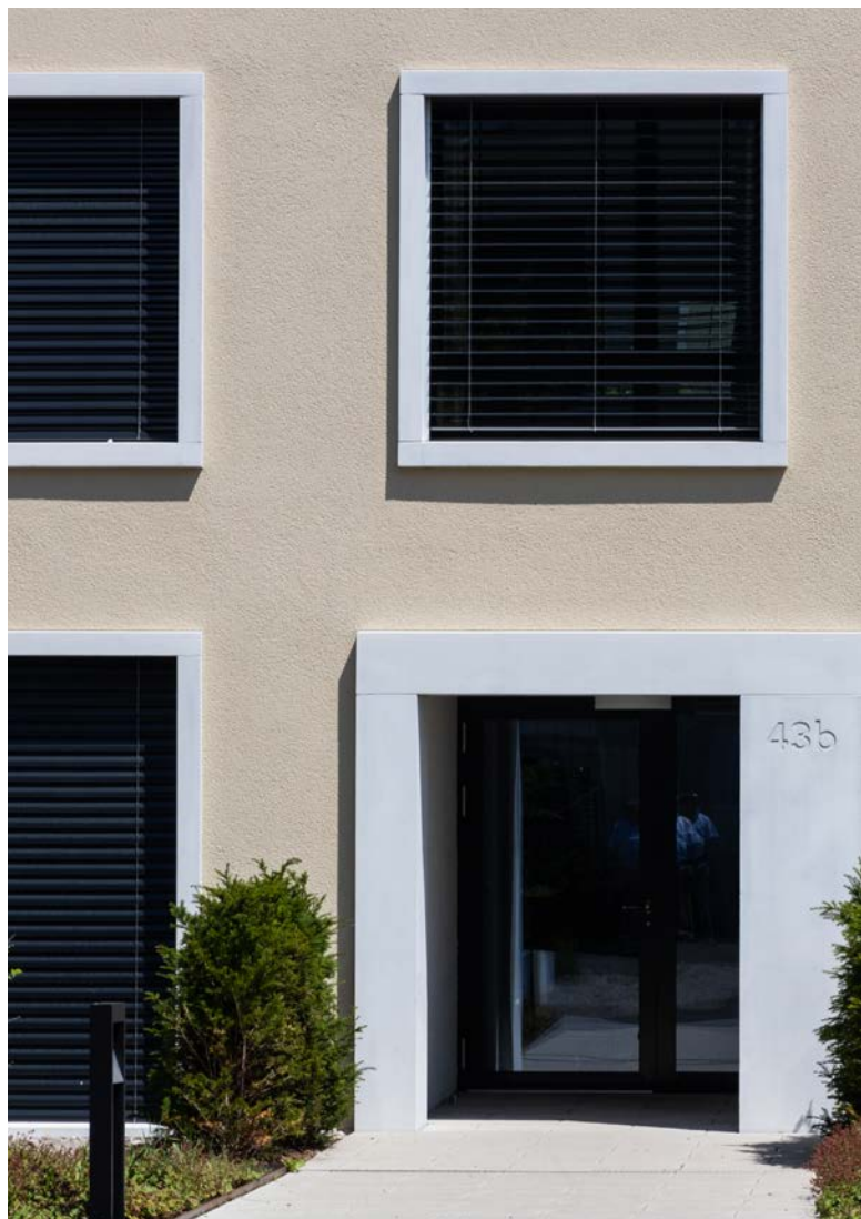
Die attraktiven Fensterumrandungen aus Glasfaserbeton des Baufelds E geben eine edle Note.
