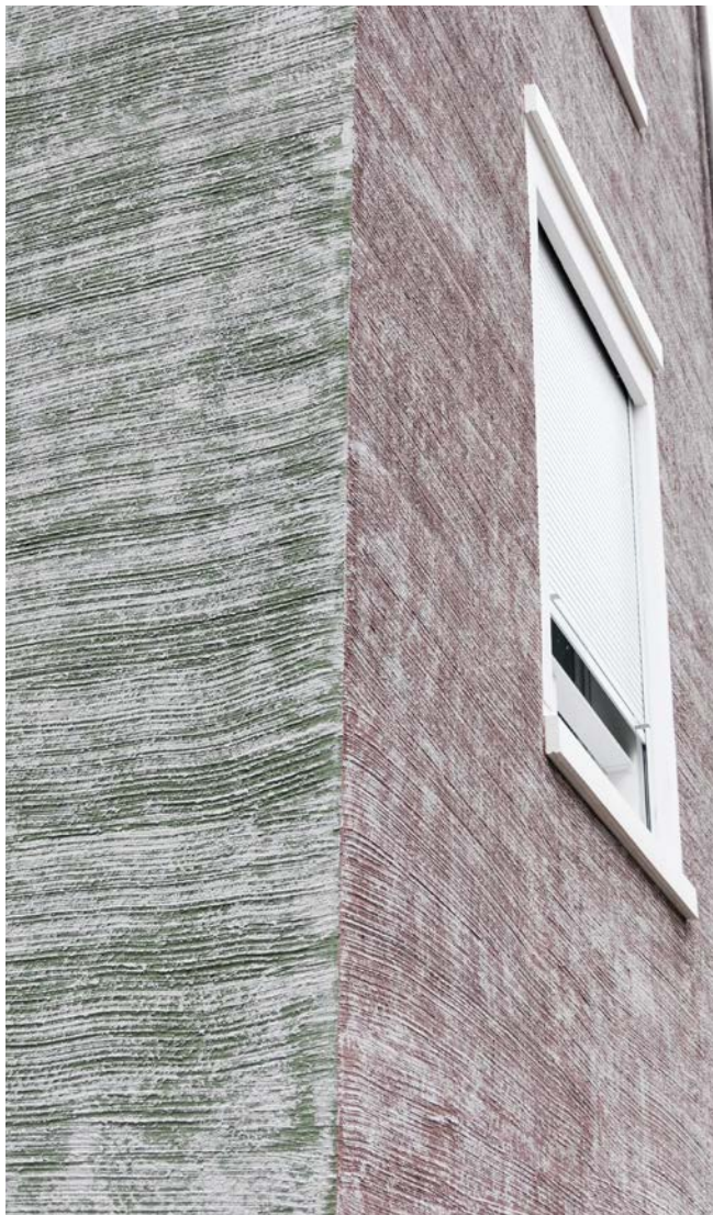
Neben Isolationswerten und Langlebigkeit erfüllt die Fassadendämmung in Grabs auch künstlerische Architekturvorgaben.
