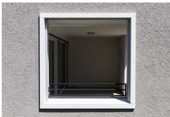
Die grobe Fassadenkörnung 4-6 mm an Baufeld C hat optisch eine starke Wirkung.
