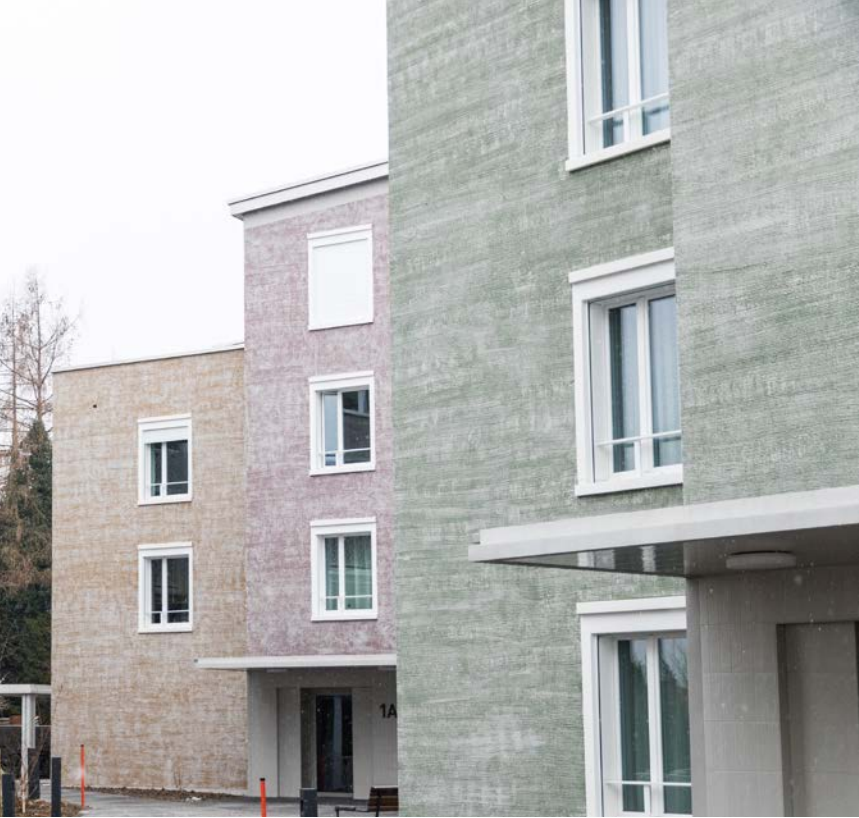
Auf den ersten Blick nicht sichtbar ist, dass die Ausführung mit regulärem Putz und Fassadenfarbe erfolgte.
