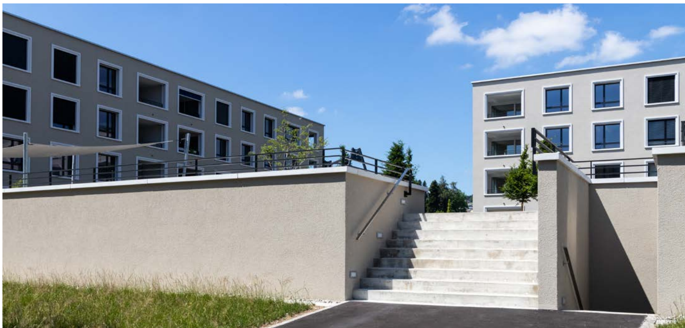
Auch das Material für die Umfassungsmauern wurde von Karl Bubenhofer AG konzipiert und bereitgestellt.
