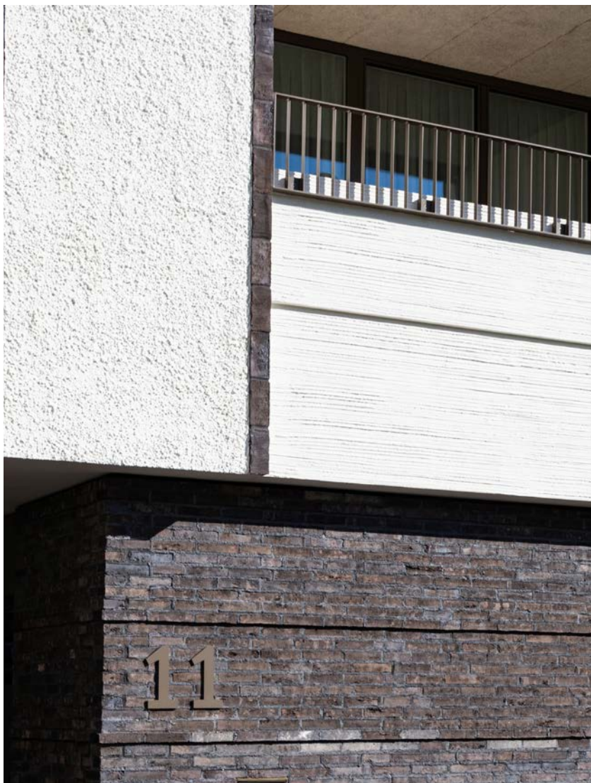
Die abwechselnden Oberflächenstrukturen, versetzten Fassadenelemente und horizontalen Bänder aus Klinkersteinen erfordern Präzision und Fachwissen in der Ausführung.
